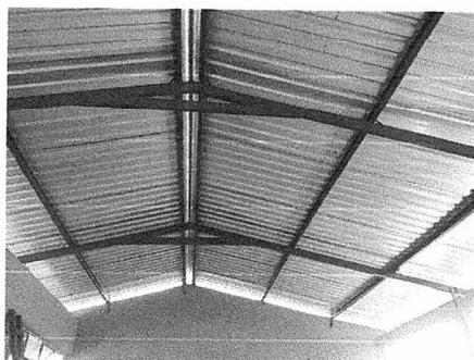
Foto1: Trabajo concluido de la sustitucion de estructura de techo y lamina de aula.
