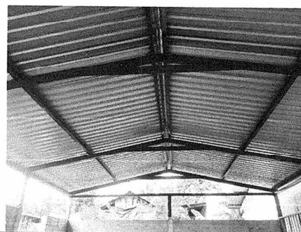
Foto 4: sustitucion de techo terminado en la cocina .
