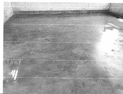
Foto 6: Sustitución de piso de cocina
